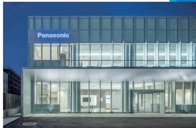
ZEB Ready施設(群馬県前橋市)
