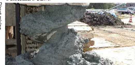
●原位置攪拌混合 ●反応性浄化壁
