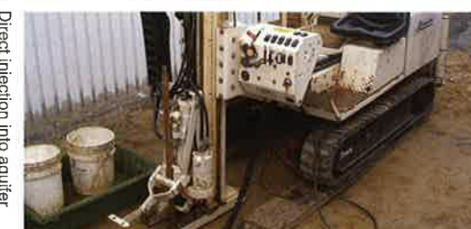
●自動式加圧注入機による直接注入
