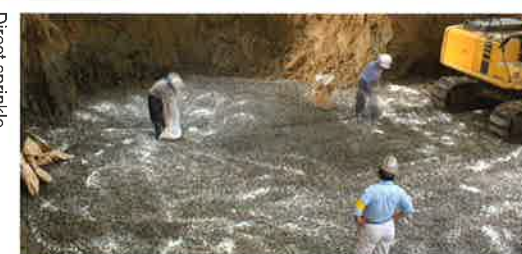
●掘削置換時散布
